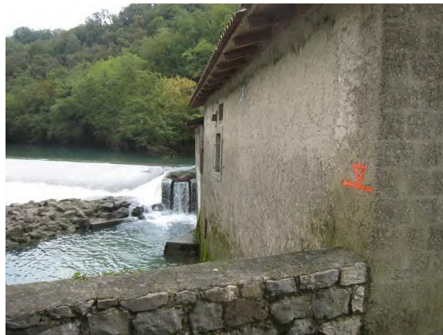
Slika 21 in 22: Oznake dosega visoke vode Vipave leta 2010 v območju mostu MV.13 – levo (kota gladine ca. 60,65m.n.v., izračunana ca. 60,82m.n.v.) in v območju jezusa Steske - desno (kota gladine ca. 64,25m.n.v., izračunana ca. 64,25m.n.v.)
