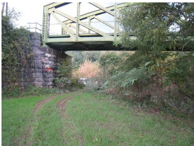
Slika 21 in 22: Oznake dosega visoke vode Vipave leta 2010 v območju mostu MV.13 – levo (kota gladine ca. 60,65m.n.v., izračunana ca. 60,82m.n.v.) in v območju jezusa Steske - desno (kota gladine ca. 64,25m.n.v., izračunana ca. 64,25m.n.v.)
