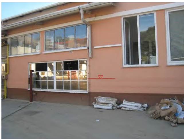
Slika 23 in 24: Oznake dosega visoke vode Vipave leta 2010 znotraj OC Batuje – levo (kota gladine ca. 68,45m.n.v., izračunana ca. 68,58m.n.v.) in na lokalni cesti na gorvodni strani obrtne cone – desno (kota gladine ca. 68,90m.n.v., izračunana ca. 68,92m.n.v.)
