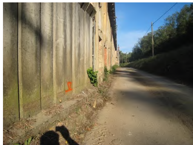
Slika 23 in 24: Oznake dosega visoke vode Vipave leta 2010 znotraj OC Batuje – levo (kota gladine ca. 68,45m.n.v., izračunana ca. 68,58m.n.v.) in na lokalni cesti na gorvodni strani obrtne cone – desno (kota gladine ca. 68,90m.n.v., izračunana ca. 68,92m.n.v.)
